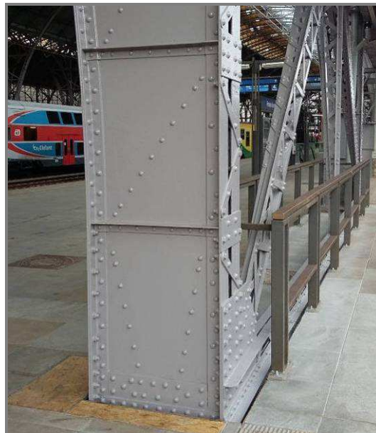
Obr. 22 Sloup 1C po dokončení oprav Figure 22 Column 1C after repair completion
