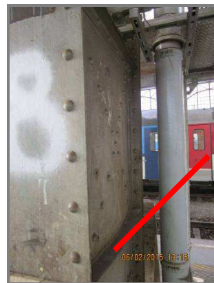
Obr. 12 Vyboulení stěn sloupů na III. nástupišti Figure 12 Bulging of column walls on platform III
