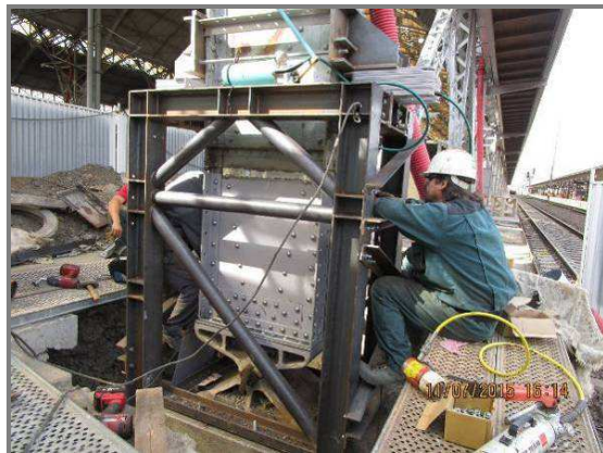
Obr. 17 Montážní sestava nové spodní části sloupu Figure 17 Installation assembly of the new bottom part of the column
