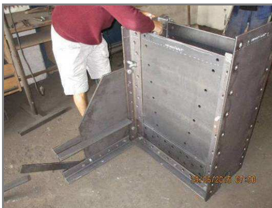
Obr. 16 Dílenská sestava nové spodní části sloupu Figure 16 Shop assembly of the new bottom part of the column
