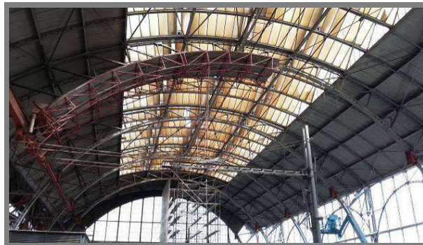
Obr. 41 Stav po demontáži poloviny rozpětí lávky Figure 41 Condition after disassembly of half of the gantry's span
