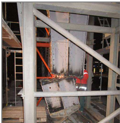
Obr. 25 Demontáž sloupu podepřeného provizorní podporou Figure 25 Disassembly of column supported by temporary supports
