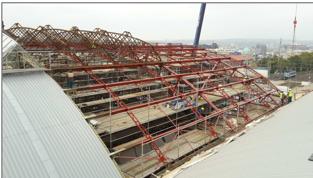
Obr. 50 Celkový pohled na montáž nových horních pasů vazníků, vaznic a propojek vaznic Figure 50 Overall view of the installation of new top bands of the girders, purlins, and purlin links
