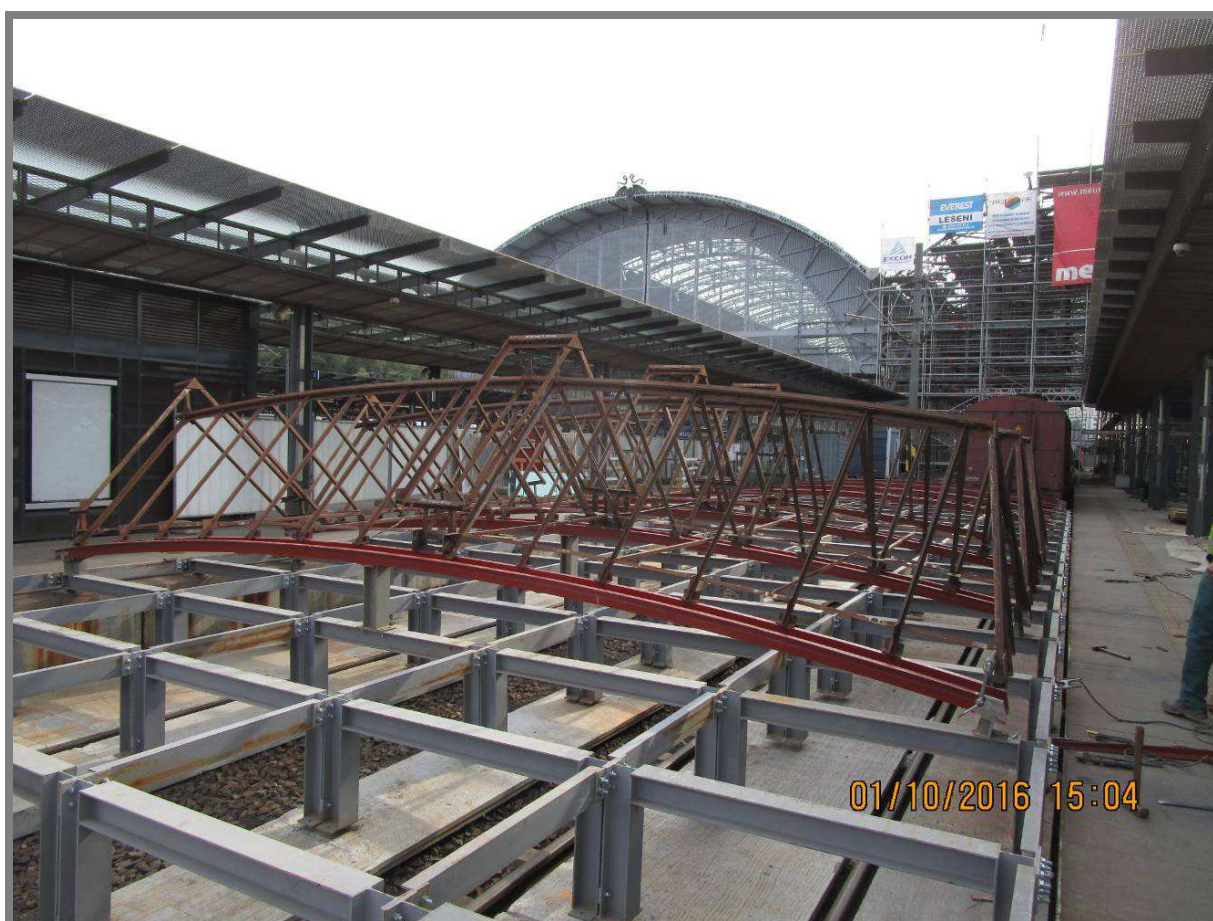
Obr. 44 Uložení světlíků na montážní stůl, kde byly světlíky opraveny, svrtány s novými světlíkovými nosníky a natřeny Figure 44 Skylights on an assembly table where they were repaired, drilled together with new skylight girders, and painted
