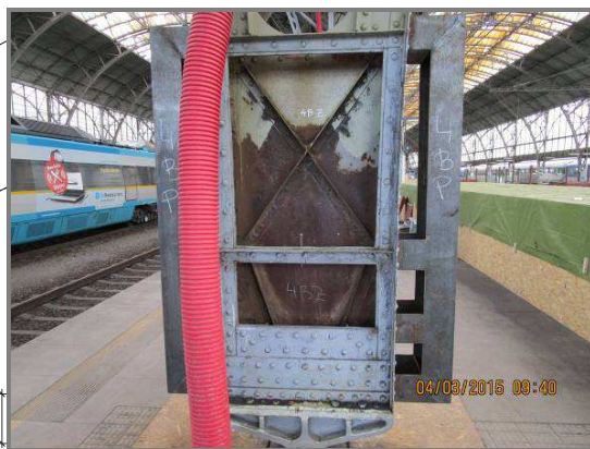
Obr. 12 Vyboulení stěn sloupů na III. nástupišti Figure 12 Bulging of column walls on platform III
