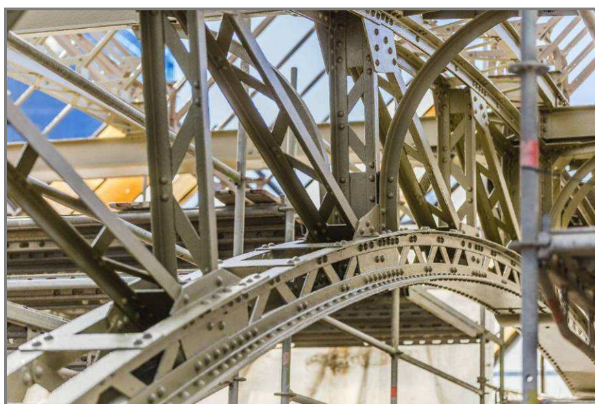
Obr. 11 Spodní pas příčné vazby po opravě a po aplikaci protikorozičního nátěru Figure 11 Bottom segment of the cross-linkage after repair and after anti-corrosion coating application
