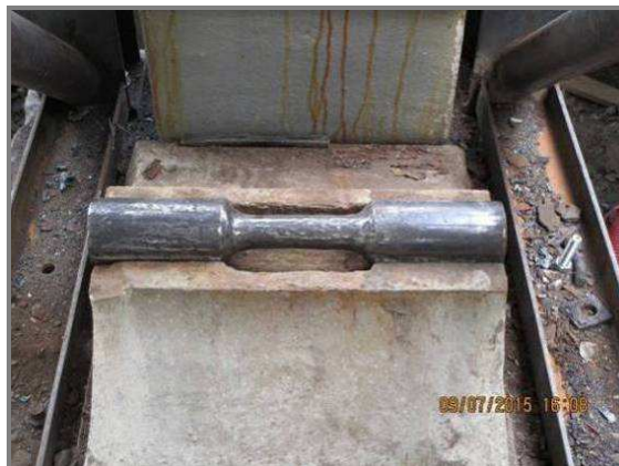
Obr. 21 Kloubové ložisko po očištění, s osazeným čepem Figure 21 Spherical bearing after cleaning, with pin installed
