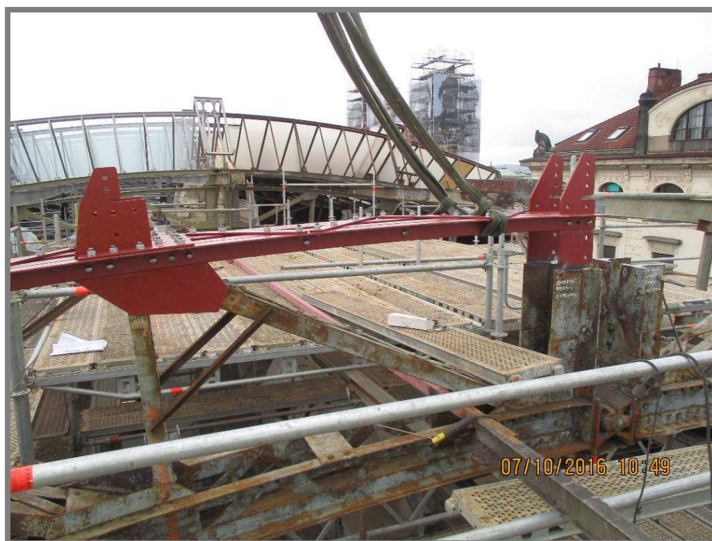
Obr. 48 Montáž nových horních pasů vazníků, otvory pro připojení diagonál a svislic vazníku byly dovrtány na míru až po usazení pasu, styčnický plech se pro vrtání dočasně vyjmul ze sestavy pasu
