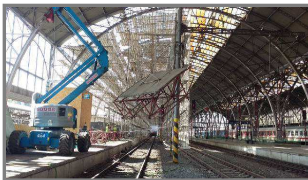
Obr. 40 Demontážní díl lávky Figure 40 Disassembled part of the gantry
