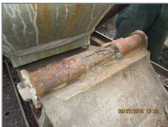
Obr. 19 Kloubové ložisko po demontáži patky sloupu Figure 19 Spherical bearing after removal of the column foot
