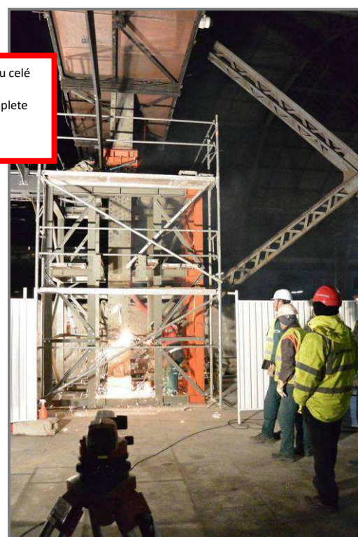
Obr. 24 Demontáž sloupu podepřeného provizorní podporou Figure 24 Disassembly of column supported by temporary supports
