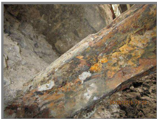
Obr. 35 Zemní táhlo 1C po odkrytí – detail nad vstupem táhla do betonového základu. Jedná se o místo s největším korozním poškozením, cca 70% poškození. Vpravo stav po opravě.
