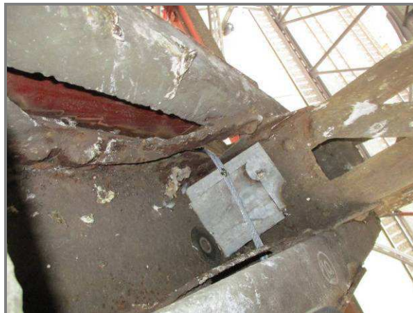
Obr. 08 Korozní poškození spodního pasu příčné vazby Figure 08 Corrosion damage to bottom segment of cross-linkage
