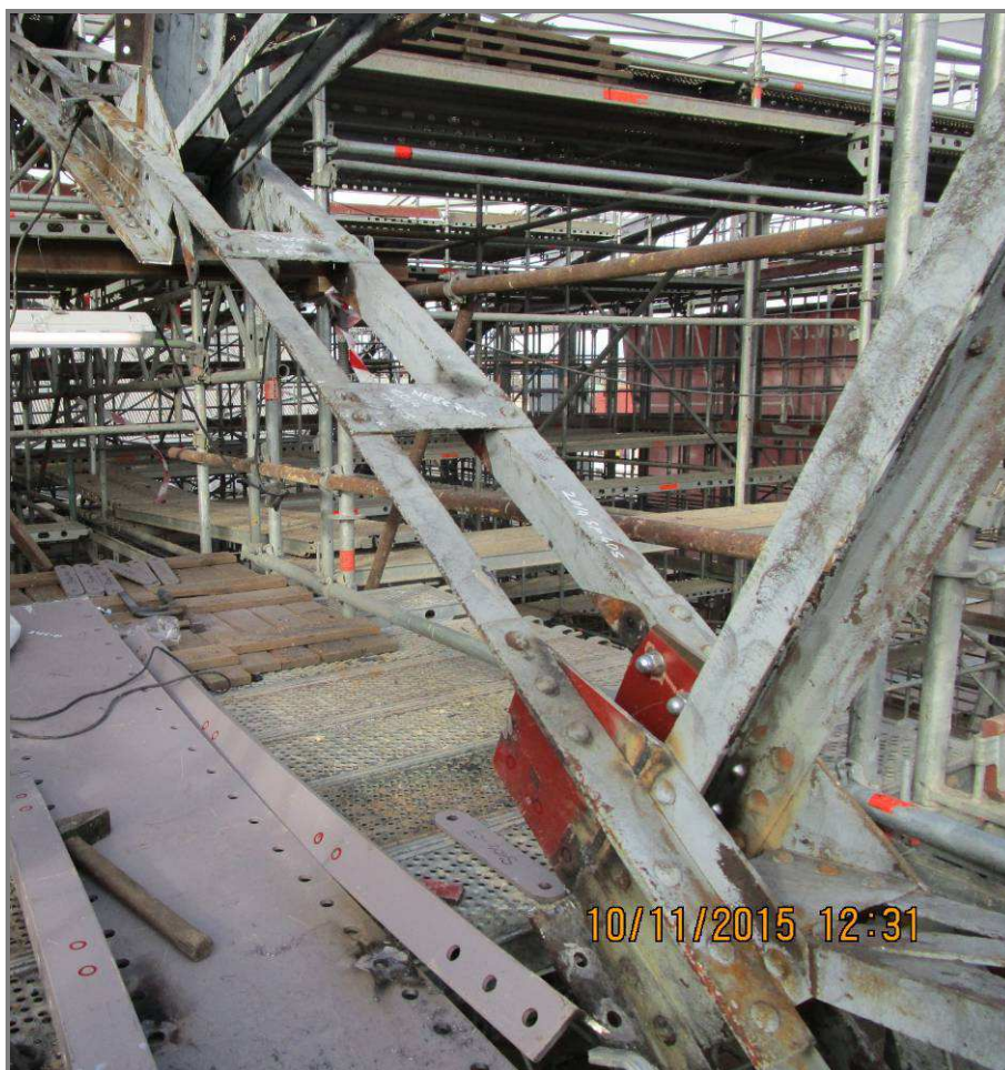
Obr. 09 Spodní pas příčné vazby během opravy Figure 09 Bottom segment of the cross-linkage during repair
