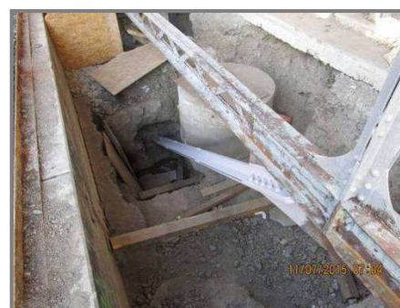
Obr. 34 Zemní táhlo 1C po odkrytí – stav po výměně Figure 34 Anchor bar 1C after exposure – condition after replacement
