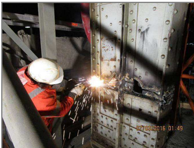
Obr. 25 Demontáž sloupu podepřeného provizorní podporou Figure 25 Disassembly of column supported by temporary supports
