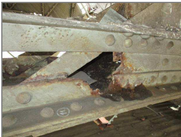
Obr. 08 Korozní poškození spodního pasu příčné vazby Figure 08 Corrosion damage to bottom segment of cross-linkage
