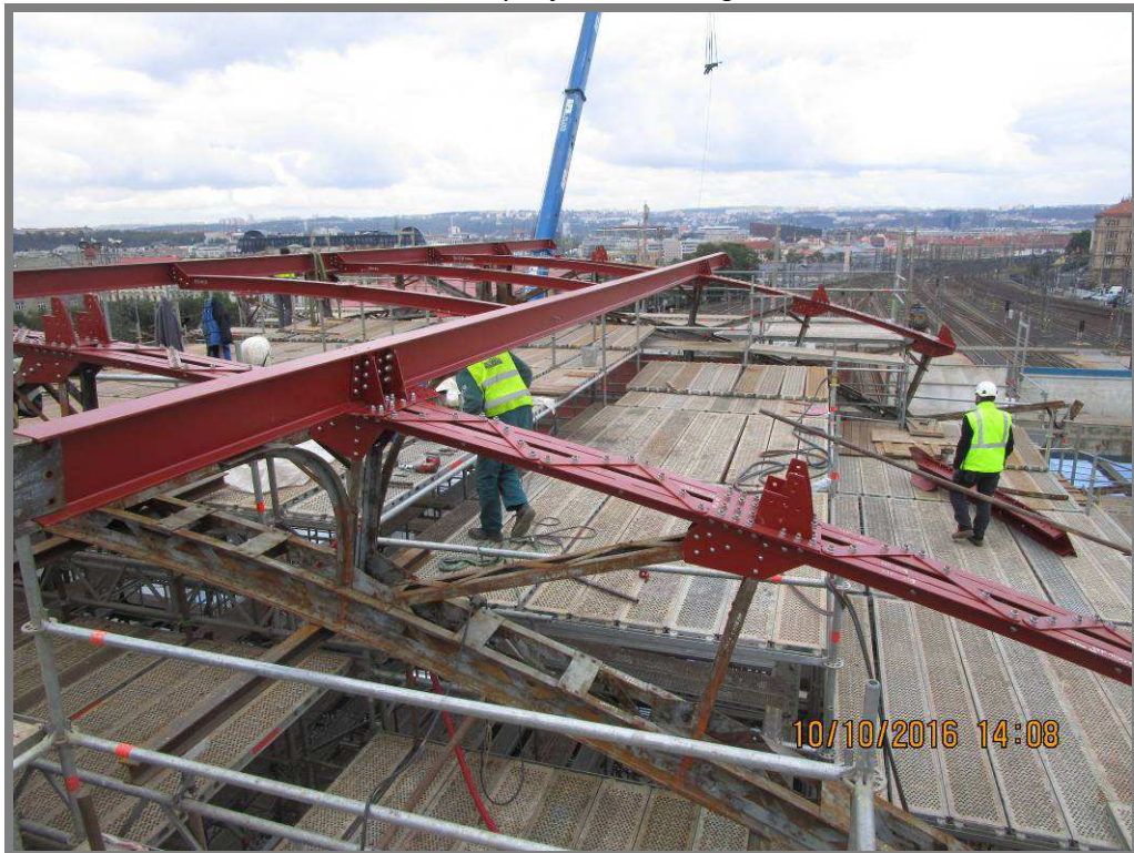
Obr. 49 Montáž nových horních pasů vazníků, vaznic a propojek vaznic Figure 49 Installation of new top bands of the girders, purlins, and purlin links
