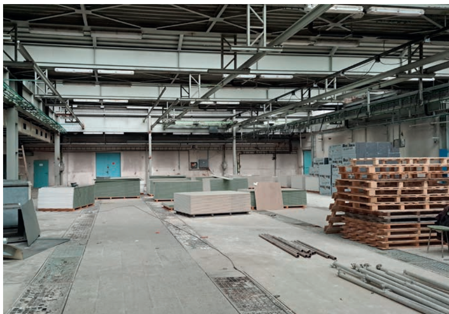
Stávající ocelová konstrukce.
