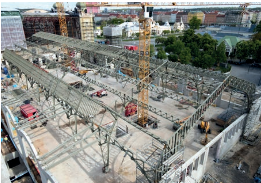
Obr. 5 – Ocelová konstrukce v průběhu montáže (květen 2024).
