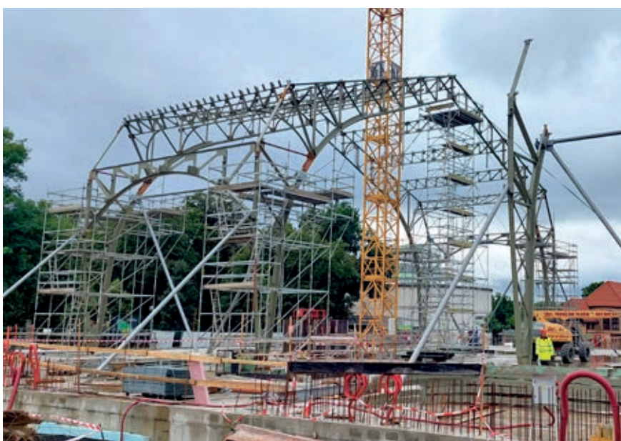
Obr. 3 – Dílenská sestava sloupu a příčle 1/2 rámu příčné vazby.
