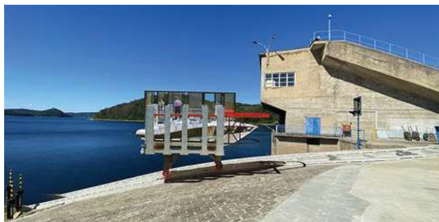
Modernizace lodního výtahu na vodním díle Orlík Ing. Tomáš Beržinský (ČKAIT 0402343, IV00)
