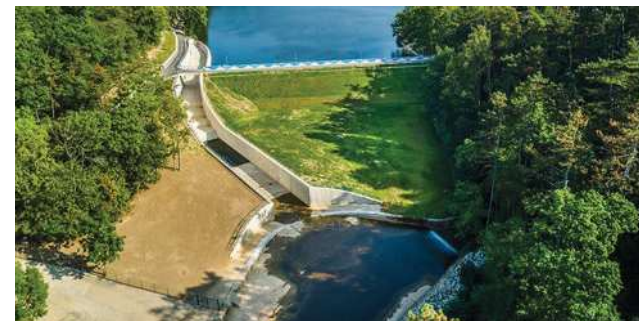
Zkapacitnění bezpečnostního přelivu na vodním díle Hostivař Ing. Olgerd Pukl (ČKAIT 0007615, IV00)
