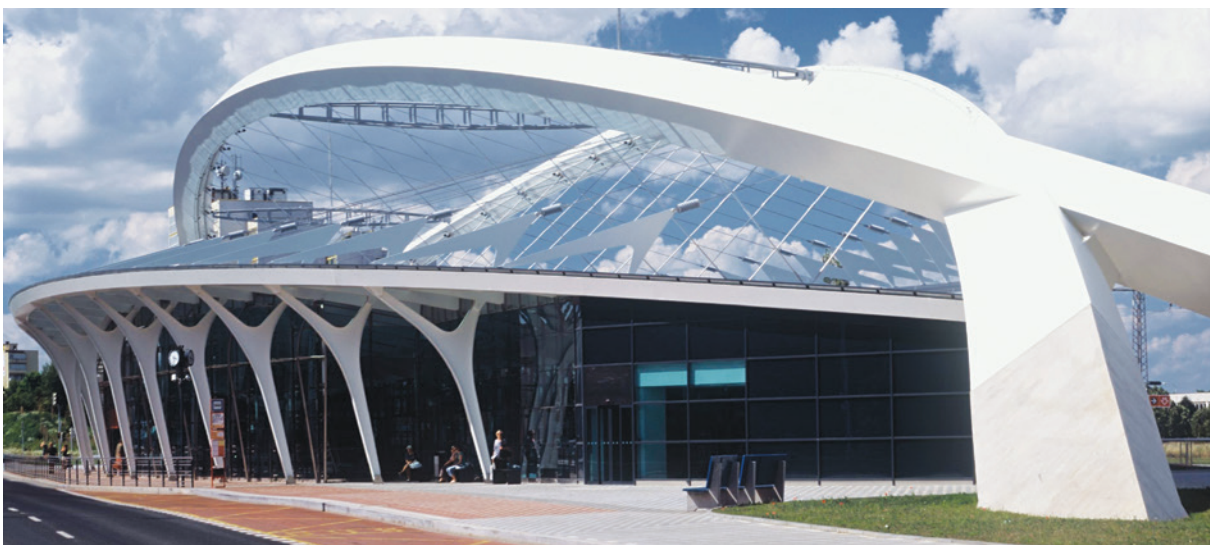
Stanice metra Střížkov, Praha, Česká republika - Dvojice hlavních ocelových oblouků o rozpětí 160 m se střechou zavěšenou na předpjatých táhlech a podpírané obvodovými sloupy.
