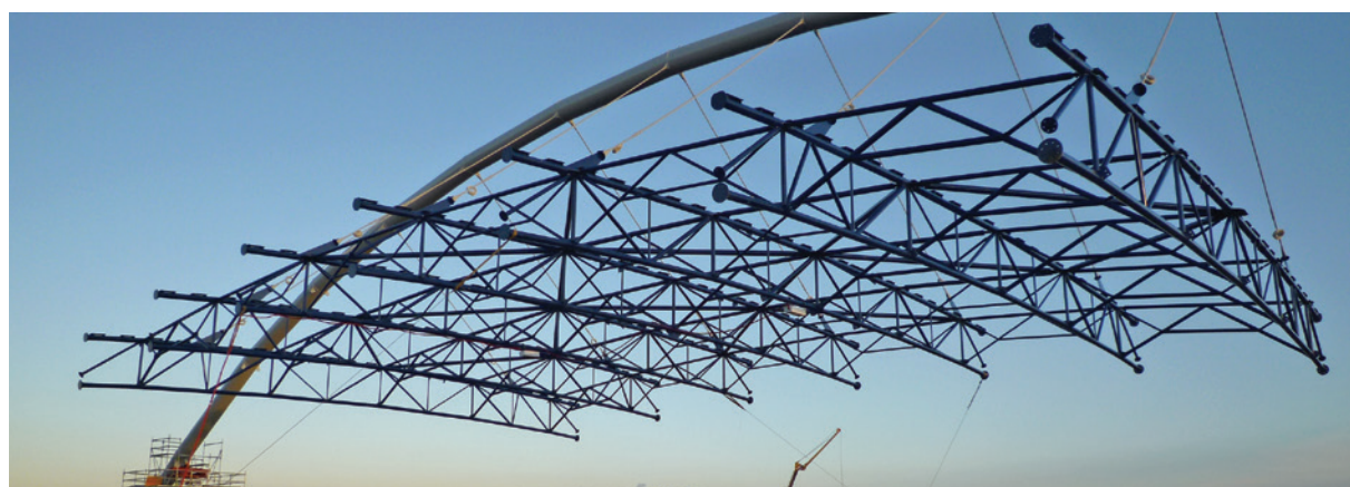
Aréna Chomutov, Chomutov, Česká republika - Ocelová střešní konstrukce zavěšená na oblouku předpjatými táhly Chomutov Arena, The Czech Republic - Steel roof structure is hung on the arch by prestressed tendons
