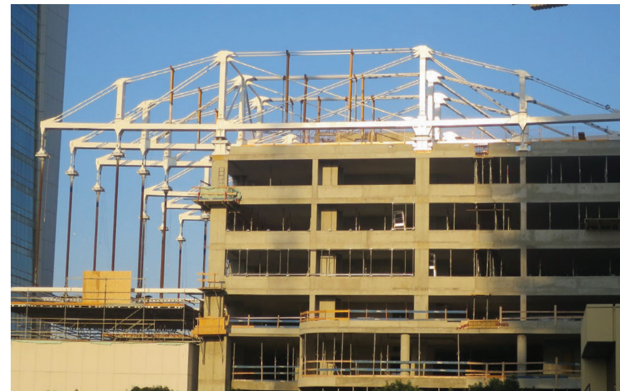
CityDeco kancelářská budova, Praha, Česká republika - Ocelová superkonstrukce s 9 vazníky a 257 předpjatými táhly, vynášející 3 a 4 patrový železobetonový skelet CityDeco office building, Prague, The Czech Republic - Steel superstructure contains 9 trusses with 257 prestressed tendons bearing 3 and 4 floors reinforced concrete structures
