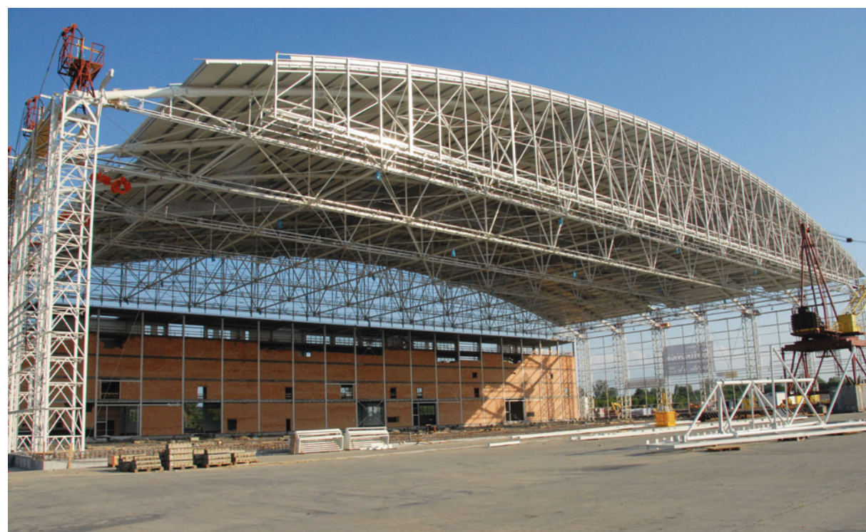
Hangár pro servis letadel, Mošnov, Česká republika - Příhradový obloukový vazník o rozpětí 140 m, s předpjatým spodním pasem Hangar, Mošnov, The Czech Republic - Truss arch of the span 140 m, with prestressed bottom chord
