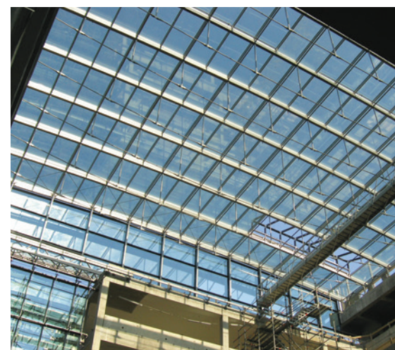
Prosklené atrium ČSOB banka, Praha – Radlice, Česká republika - Předpjatá ocelová vzpínadla Glased-in atrium of the ČSOB bank, Prague – Radlice, The Czech Republic - Prestressed beam – string structure
