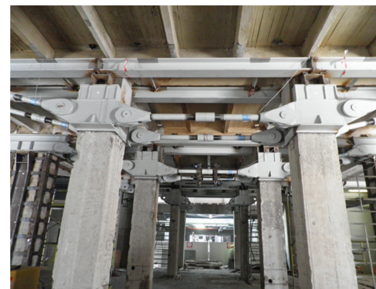
Kancelářská budova Florentinum, Praha, Česká republika - 8 vzpínadel vynášejících 5 pater původní budovy po vybourání nosných sloupů v přízemí Florentinum office building, Prague, The Czech Republic - 8 beams strings bearing 5 floors building after dismantling of supporting columns in ground floor
