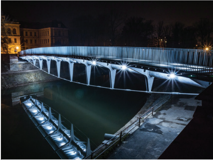
Komenského lávka pro pěší, Jaroměř, Česká Republika - Ocelová konstrukce s mostovkou a s centrálním trubkovým nosníkem, jehož stabilitu a tuhost zajišťuje trojice předpjatých táhel, rozpětí 61,5m
