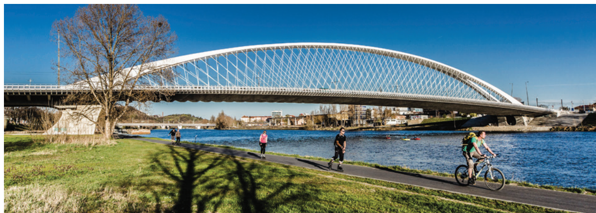
Trojský most, Praha, Česká republika - Železobetonová mostovka zavěšená sítí předpjatých táhel do ocelového oblouku, rozpětí 200 m Troja Bridge, Prague, The Czech Republic - Reinforced concrete bridge deck is hung into the steel arch by the prestressed tendon's network, span of 200 m
