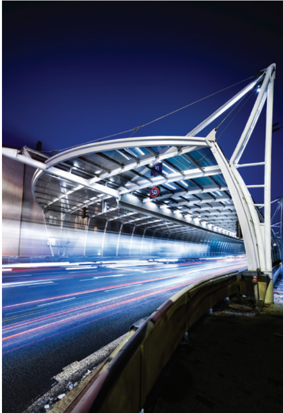
Protihlukový tunel, Hradec Králové, Česká republika - Konstrukce zavěšená na systému předpjatých táhel Anti-noise tunnel, Hradec Králové, The Czech Republic - Structure is hung on the system of prestressed tendons
