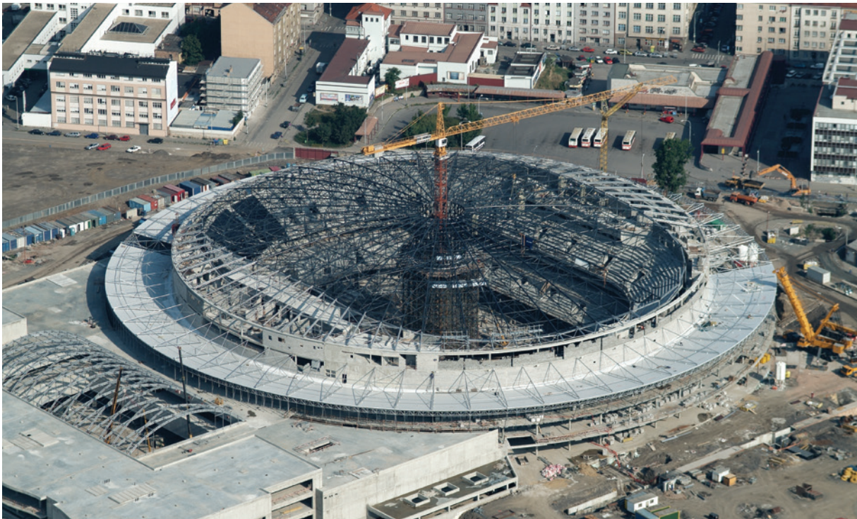
O2 Arena, Praha, Česká republika - Předpjaté prostorové vzpínadlo O2 Arena, Prague, The Czech Republic - Prestressed space beam-string structure
