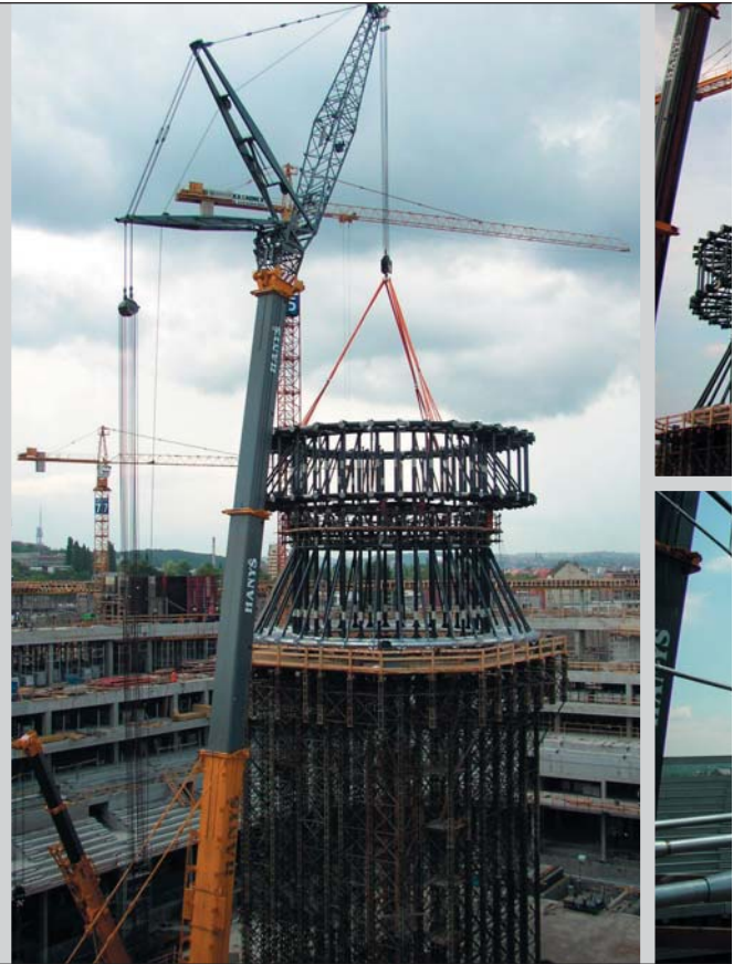
Výroba, montáž, předpínání táhel a aktivace ocelové konstrukce střechy Fabrication, Erection, Prestressing and Activation
