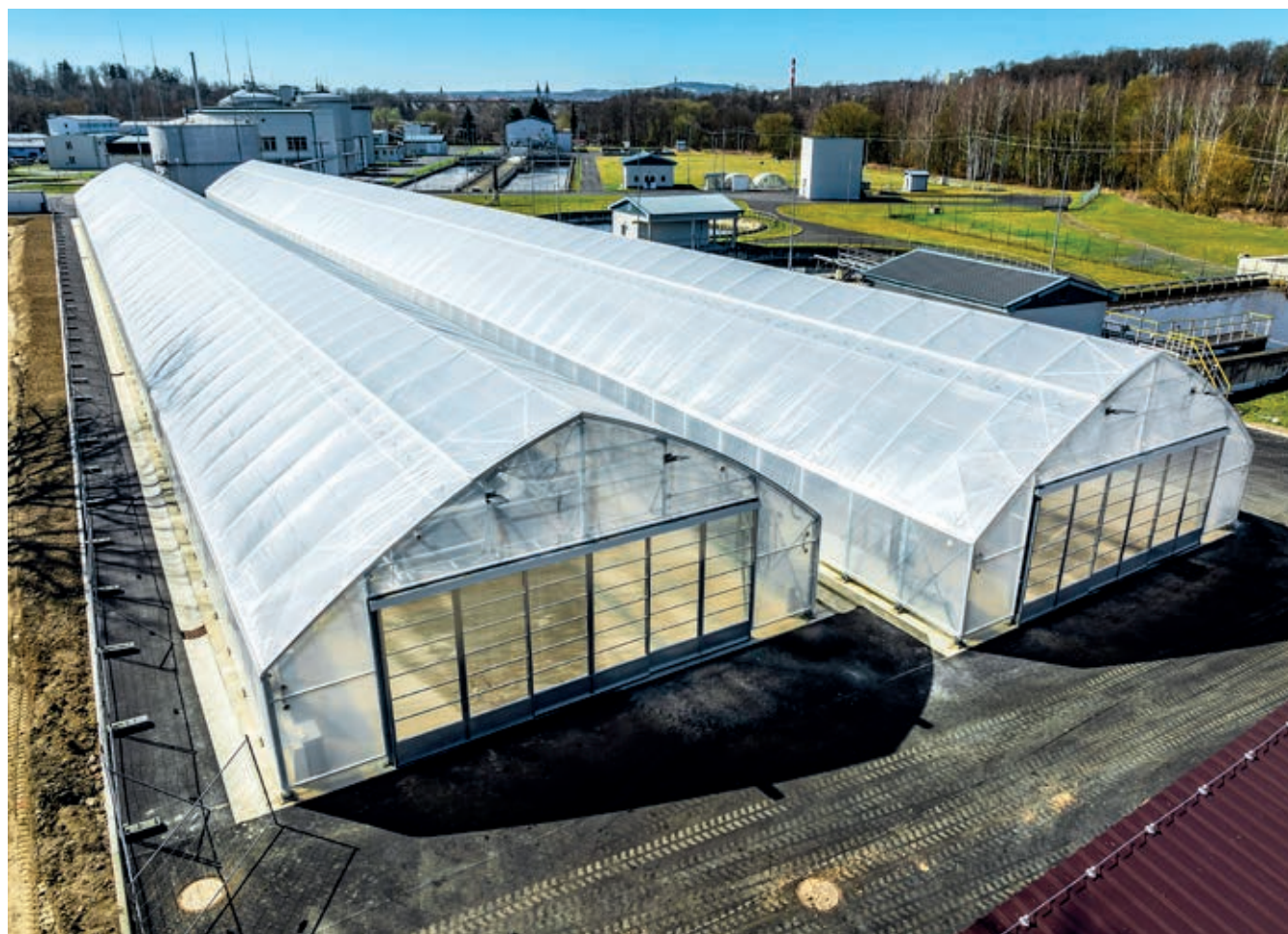
Pohled na dokončené haly sušárny.
