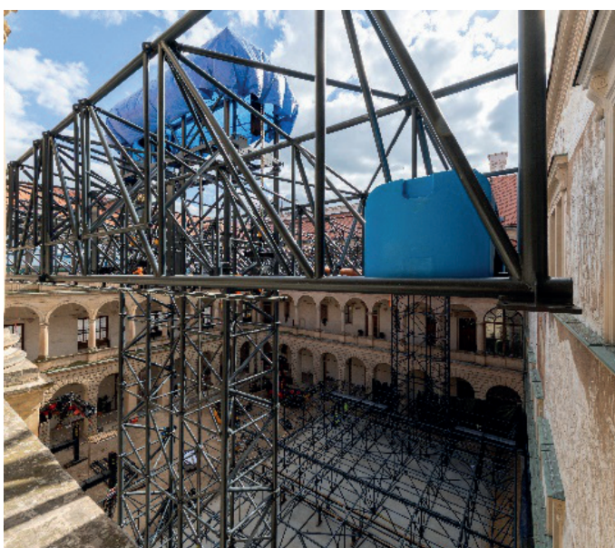
Obr. 3–9 Postup montáže ocelového zastřešení prostoru druhého nádvoří zámku, zdroj: EXCON, a.s.
