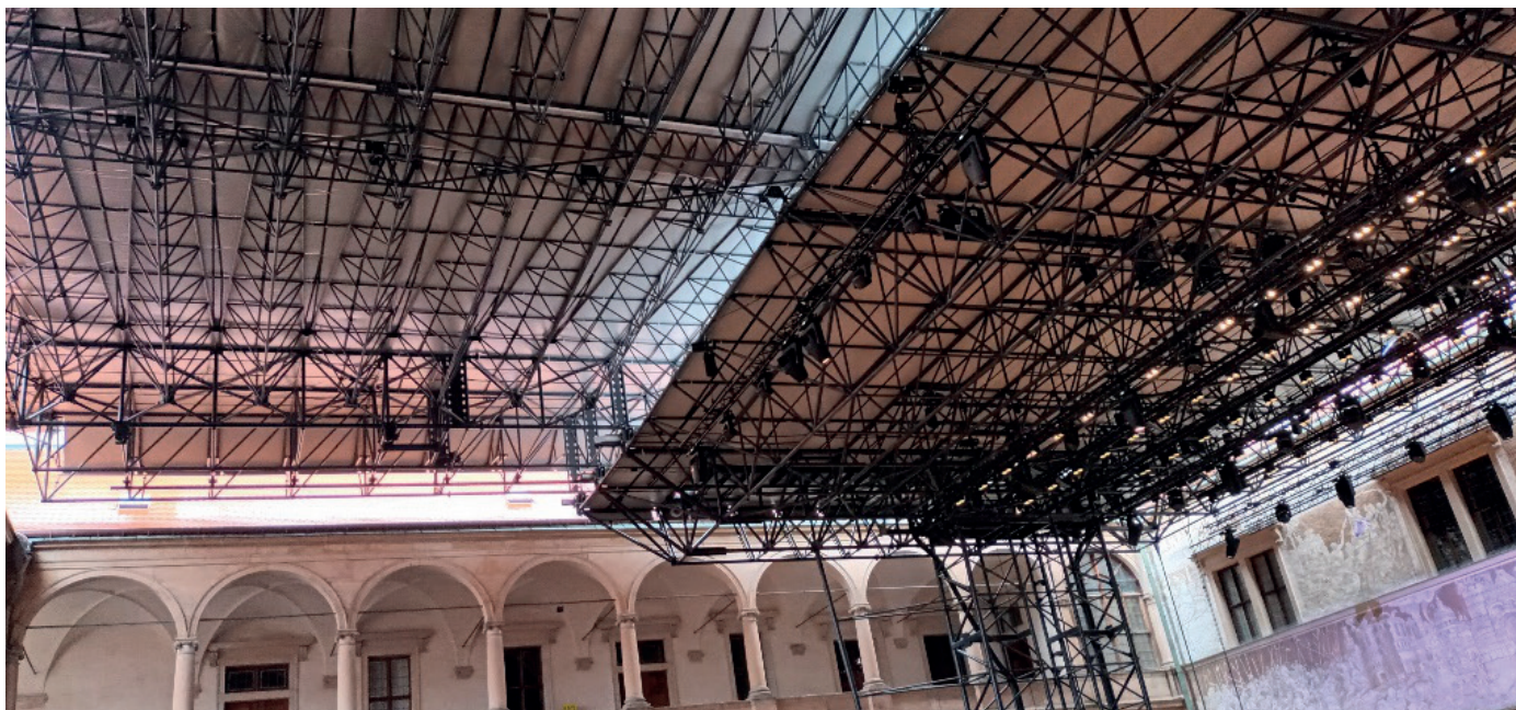
Obr. 10 Ocelové zastřešení prostoru druhého nádvoří zámku, zdroj: AP ateliér
