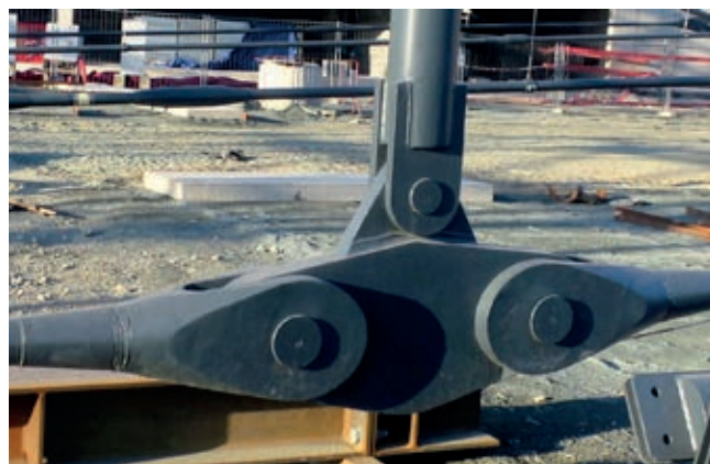
Obr. 7 – Připoj táhel a vzpěry vazníku.
