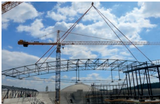
Obr. 14 – Montáž dvojice vazníků a montážní konstrukce pro 1/2 válce.
