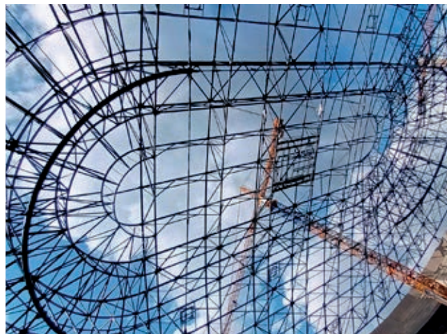
Obr. 3 – Konstrukce střechy, pohled zdola.
