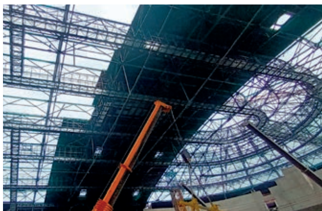
Obr. 12 – Podvěsné lávky po montáži.
