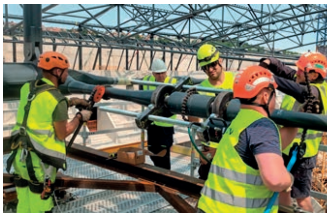
Obr. 16 – Předpínání středního táhla krajního vazníku hydraulickým zařízením.
