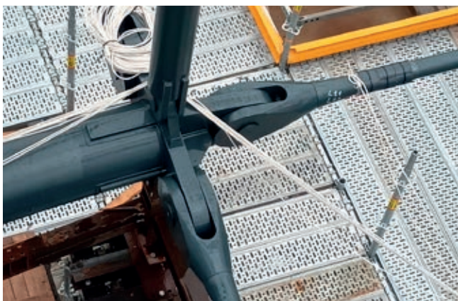
Obr. 9 – Připoj dlouhého táhla ke kruhové trubce.
