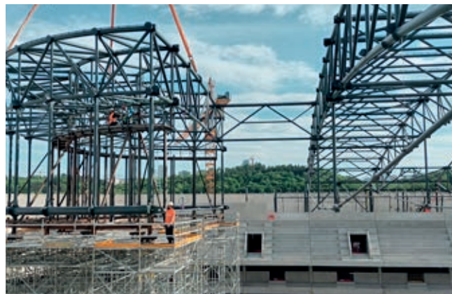
Obr. 15 – Montáž příhradových 1/2 válců na montážní věži PERI.
