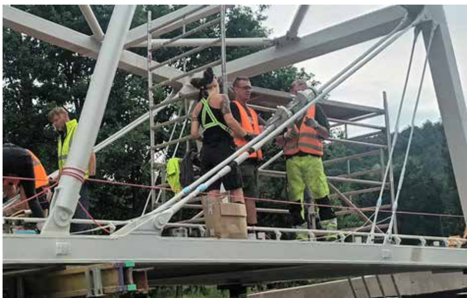
Obr. 8 Připoje mezipasových prutů a montáž Technotensionerů na táhla
