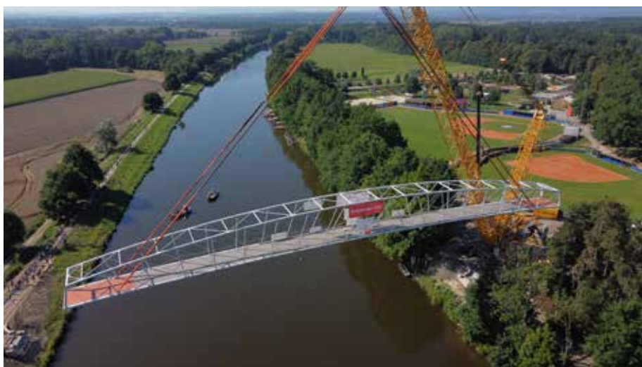
Obr. 9 Montáž lávky jeřábem LIEBHERR LR 1750
