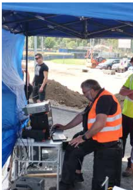
Obr. 11 Měřicí stanoviště pro dynamickou zkoušku
