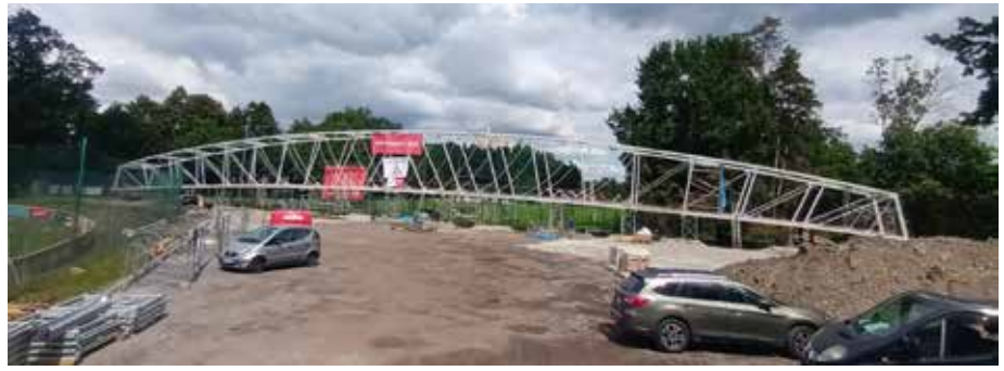
Obr. 5 Předmontáž lávky na montážních podporách
