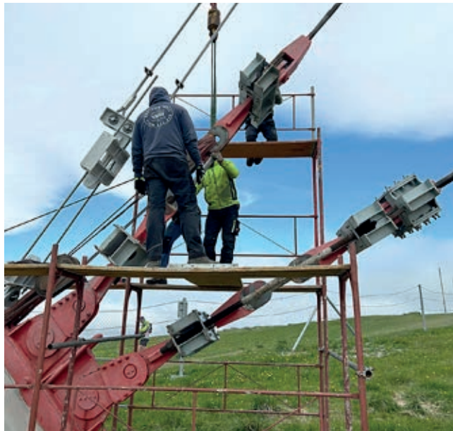
Obr. 12 – Provizorní kotva, povolení stávajícího lana.
