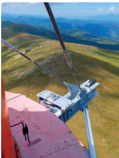
Obr. 9 – Montážní kladky nad 2. kotevní úrovní.
