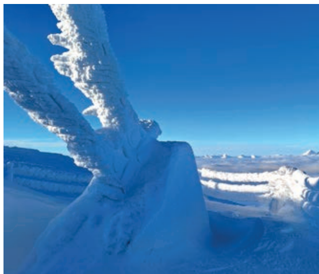
Obr. 7 – Namrzlé kotvení lan.
