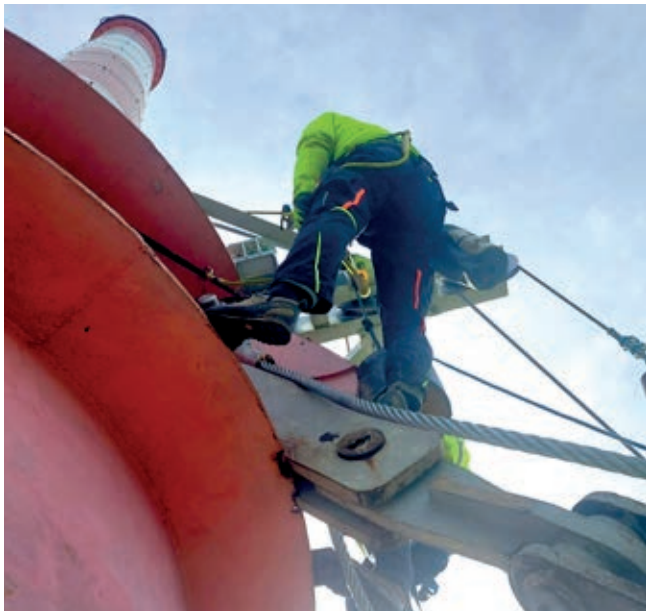
Obr. 11 – Montáž provizorní kotvy.
