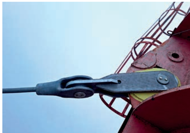
Obr. 3 – Přikotvení lana k dříku (nové).
