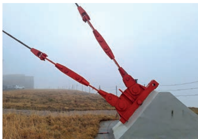
Obr. 4 – Původní zařízení pro napínání a ukotvení lan.
