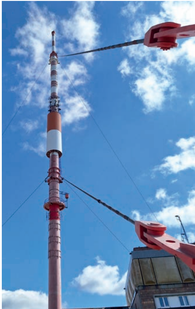
Obr. 1 – Kotvený stožár Králova hoľa.
